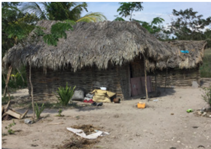
Onbewoonbaar verklaarde woning. Instortingsgevaar als je deur opendoet.
