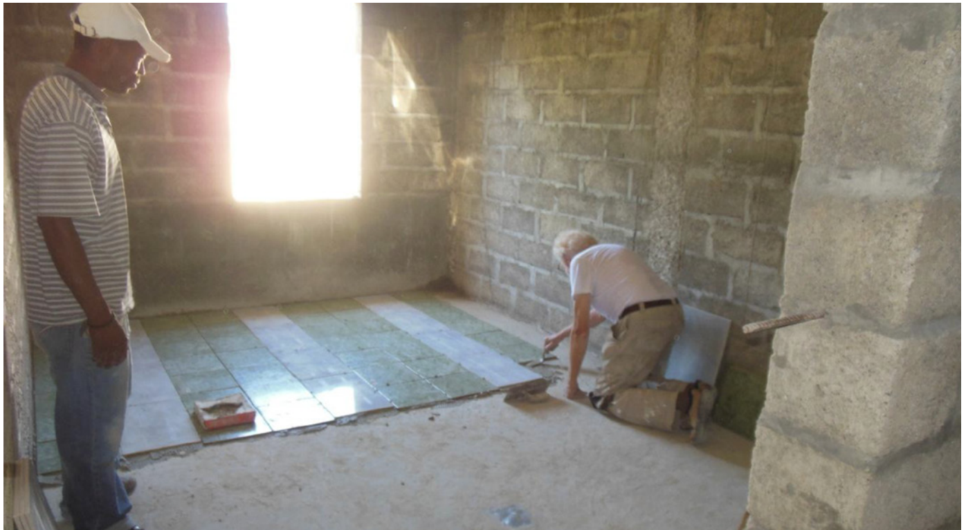
Henk aan het tegelen van de verdieping.
