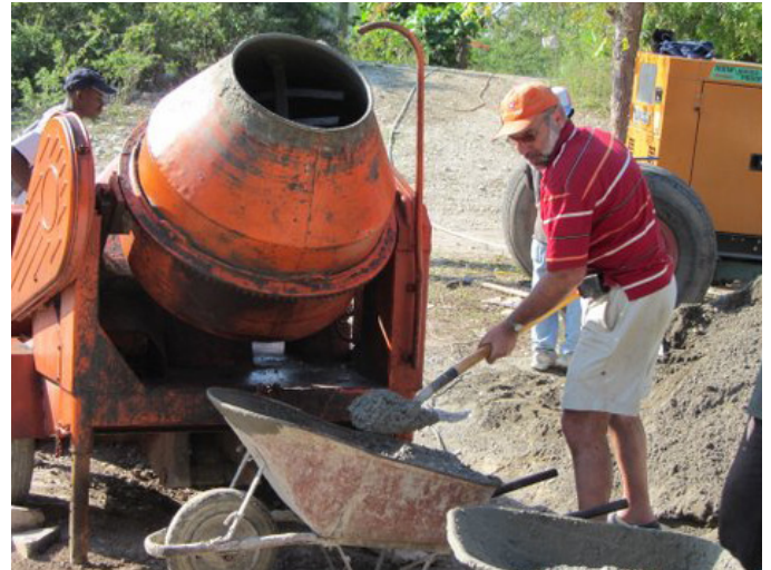
De betonmolen met machinist en aggregaat.
