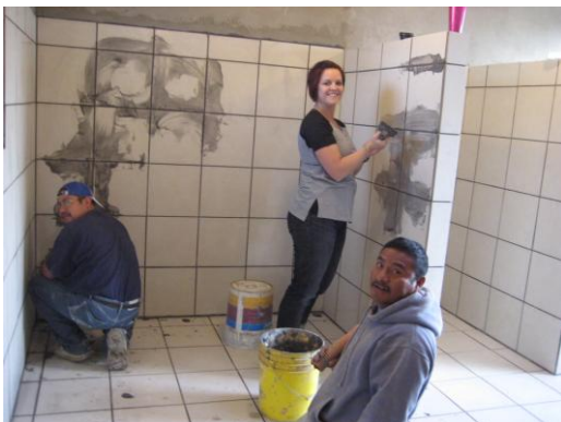
Het nieuwe uitgebreide toiletgebouw
